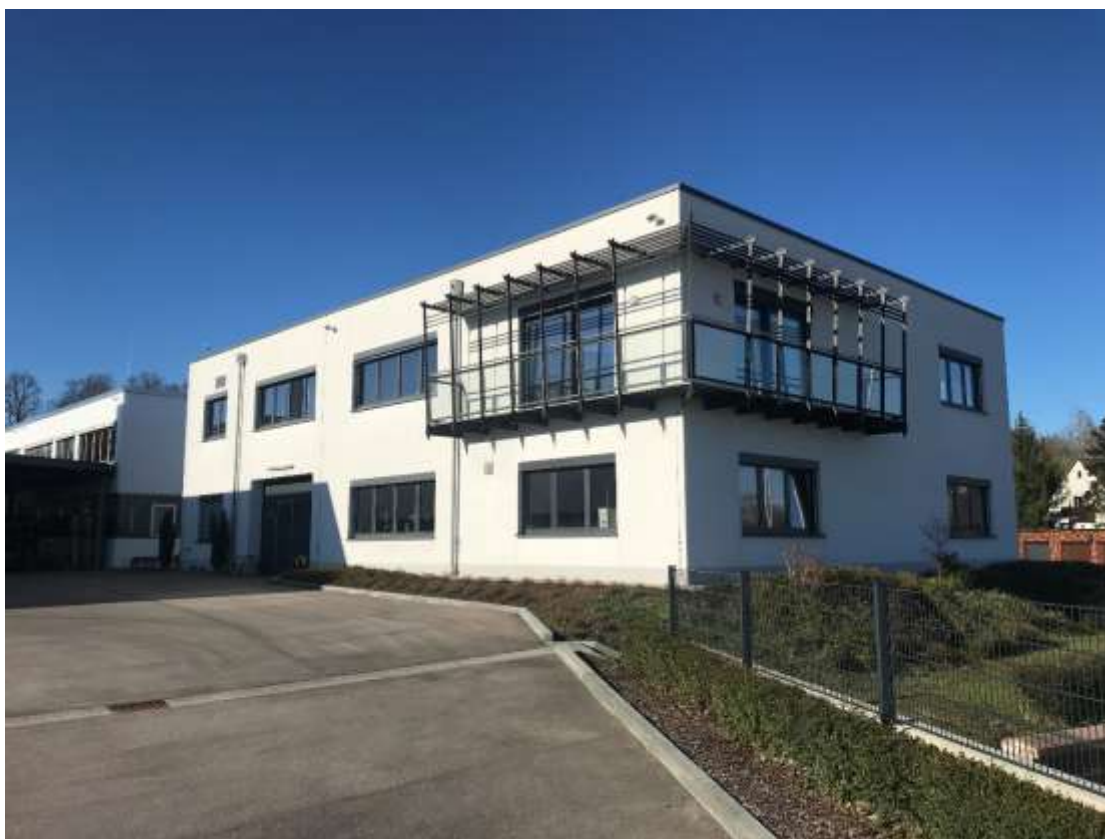
Foto 3: Ansicht Verwaltungsgebäude und Werkzeugbau
