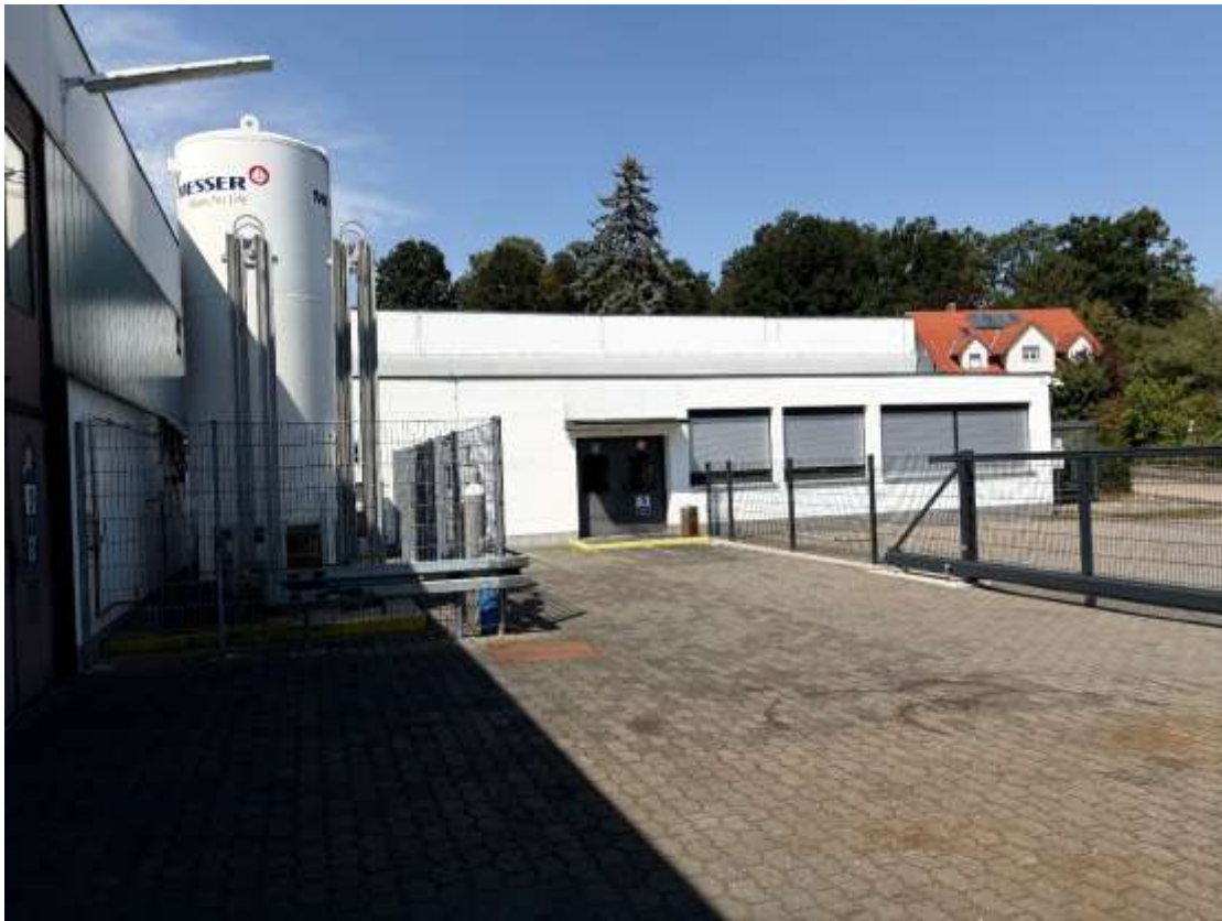
Foto 5: Ansicht Hof Nord mit N2-Gastank; Hintergrund Halle 2
