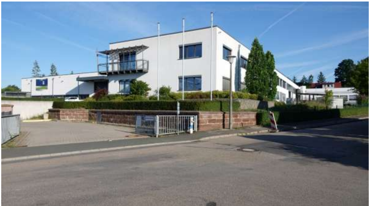
Foto 2: Ansicht von der Ringstrasse (von Süden nach Norden)
