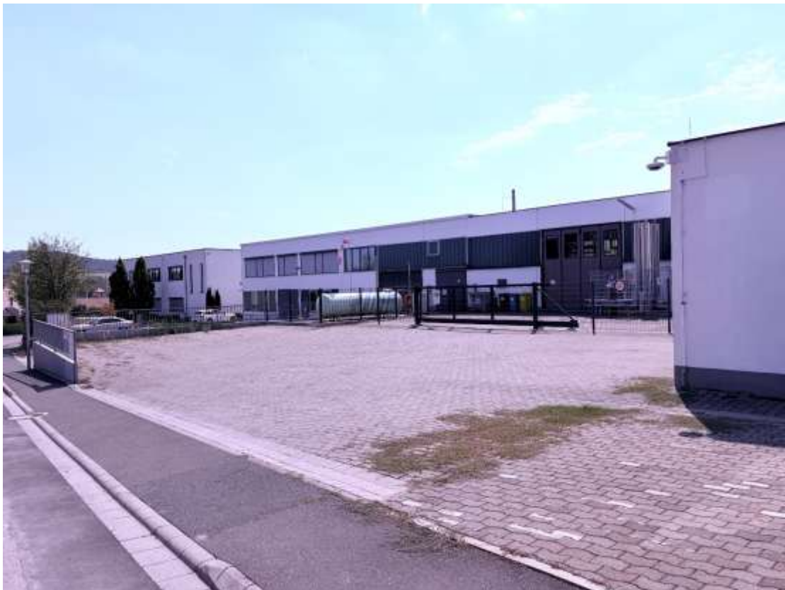
Foto 6: Ansicht Hof Nord von der Ringstrasse aus mit Blick auf Halle 4, 5, 6, 8
